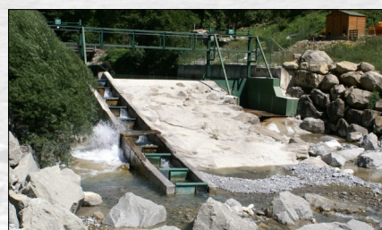
Seuil avec passe à poisson sur le Var
