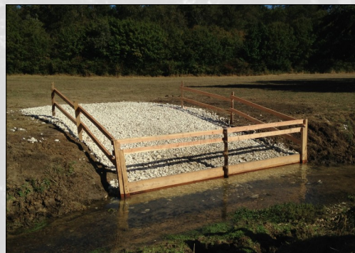
Descente aménagée avec traverses en bois
