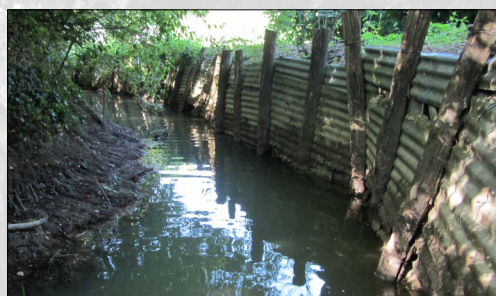
Protection de berge en tôle
