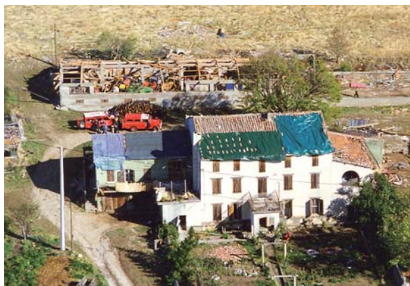
La campagne Bayard après le passage de la tornade du 8 septembre 1994.
